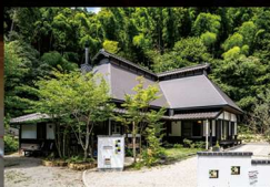
屋根は断熱性のある古い茅葺きをそのまま残し、上からガルバリウム鋼板で覆っている
