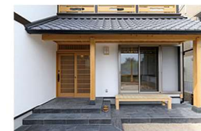
料亭や旅館を彷彿させる純和風の玄関。スペイン漆喰の白といぶし瓦、無垢材のコントラストが絶妙
