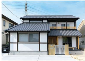
耐水性、耐火性、耐寒性などに優れたいぶし瓦を採用。外壁はスペイン濃焼仕上げ
