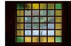
建具も一つずつすべてオリジナルで製作。唯一無二のデザインを職人技で仕上げた丁寧な作りこみでじっくり見て確かめてほしい
