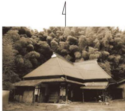
BEFORE 施工前は日本各地で観られる数々の古民家だった。新建材で造られた増築部分は朽ちていたが、天然の木材で造られた母屋は活かすことができた
