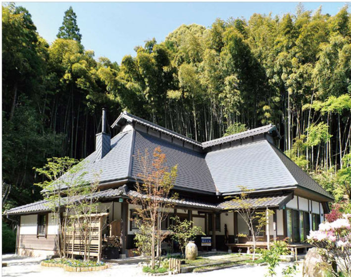
AFTER リノベーション後の外観。屋根の茅葺は残し、その表面をガルバリウム材で覆うことで良い状態を維持。庭を愛でられるように設備も増設された
