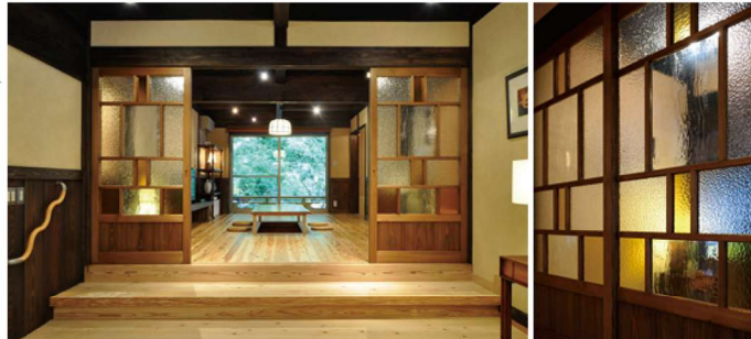
左、建物の基礎にコンクリートを打ち、湿気や冷気を和らげることに成功。右、土間と室内を仕切る引き戸は、海外のガラスを用いた【ハウスランド社】の造作
