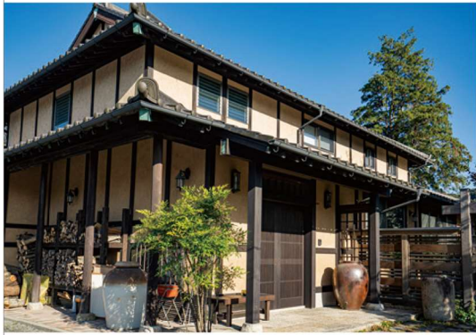
スペイン漆喰の外壁はカビや苔に強いアルカリ性で、メンテナンスコストを抑えることができる。「壁についた汚れも、いつの間にか消えた」とお客様から聞きました！
