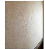
室内壁の多くはスペイン産の 塗り壁。空間の雰囲気に 合わせて塗り方も変えている
