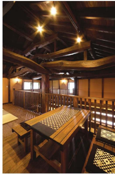
再生前すべてが傾斜だった二階部分は、天井を取り払い、一部を吹き抜けに変更。開放的になった空間に太い梁の架がオブジェのように映える
